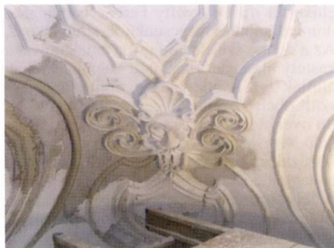
7. A díszterem habarcs-stukkó dísz restaurálás közben. A szerző felvétele
